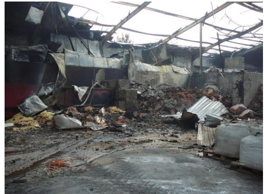
Brandschaden in einer Biogasanlage bei Billerbeck. Beprobung der Brandabfälle, hier geschmolzene Schokolade (07/2012).
