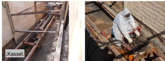
16.-20.08.12 → Durchführung der Horizontalbohrung für Regenwasserkanal, Separation PAK-/Teeröl-verunreinigtes Bohrgut in Container
