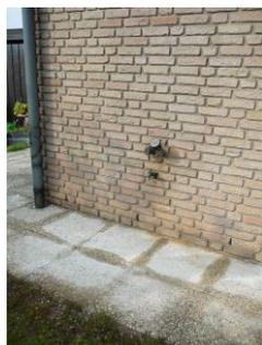
Bilder inks/unten: Heizölbefüllschaden im Kreis Minden-Lübbecke, Schadenbeseitigung durch Fassadenreinigung und Aushub der ölverunreinigten Böden (09/2009).
