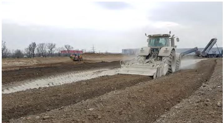
Bereichsweise wurden acht Lagen Boden (jew. 0,3 m mächtig) eingebaut. Es erfolgte eine kontinuierliche Überprüfung der Tragfähigkeit des eingebauten Bodens mittels statischer
