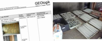
Überprüfung der Entwässerungssituation im Gebäude, vor allem im Bereich der Abhangdecken. Freilegen einer Vielzahl von Asbestzementrohren. Das gesamte Ausmaß konnte erst im Verlauf der Entkernung erkannt werden.
